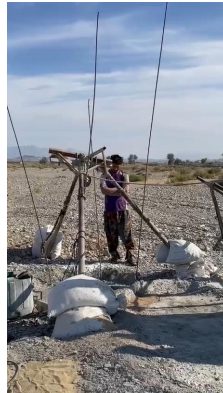
حفاری چاه آب جدید
